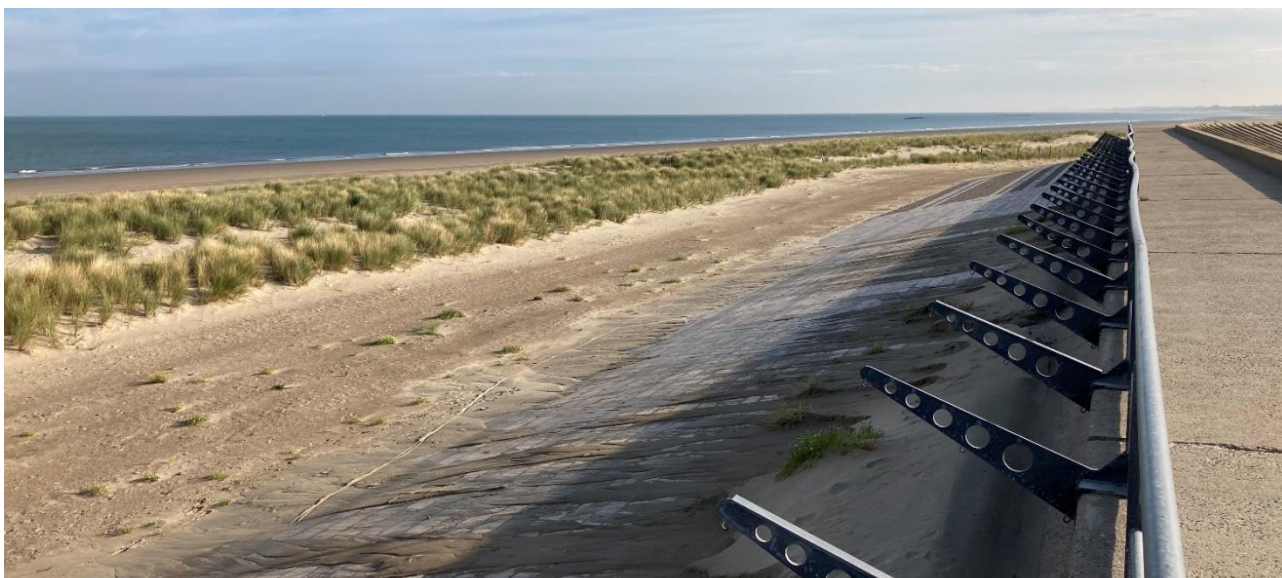
Cordon dunaire artificiel érigé au-devant de la digue des Alliés - Plage de Malo-les-Bains. © LOG – E. Blaise (2022)
