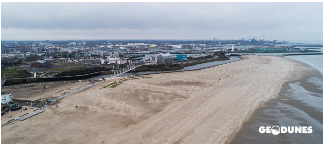
Plage de Malo-les-Bains (secteur ouest), la digue des Alliés à Dunkerque et le canal exutoire © Géodunes
